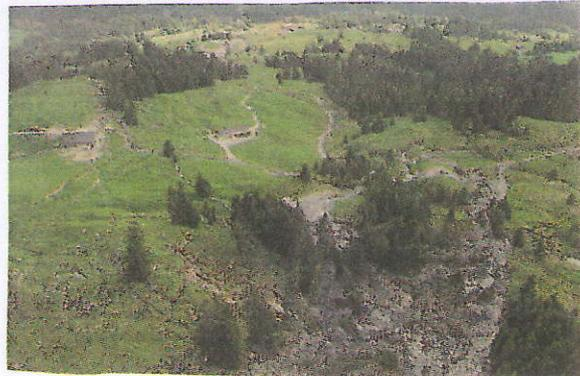
Eine weitere Ursache für die Rutschung waren sicher die intensiven Regenfälle in der letzten Zeit. Denn der Boden konnte das viele Oberflächenwasser nicht mehr aufnehmen. Deshalb hat auch die Feuerwehr das ganze Oberflächenwasser in Rohren zusammengefaßt und in unbewohntes Gebiet geleitet.
